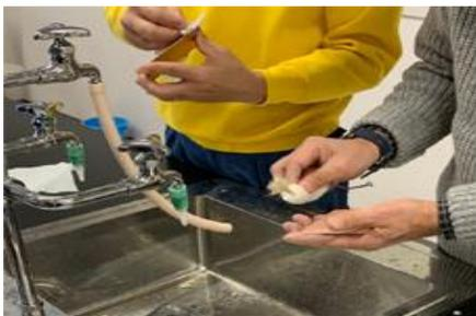
図。クレンザーで洗浄してさびなどを落とす
